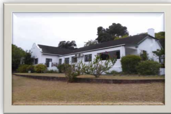
Das Hauptgebäude mit Empfang, Büro der Geschäftsleitung mit Sekretariat, Büro der Oberschwester und der Hospiz-Schwestern,
